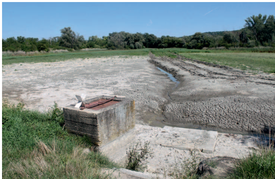
Dolní mušlovský rybník, pohled z hráže dne 15. srpna 2017. Vpravo na snímku probíhá mulčování vegetace. (foto Vlastimil Sajfrt)
