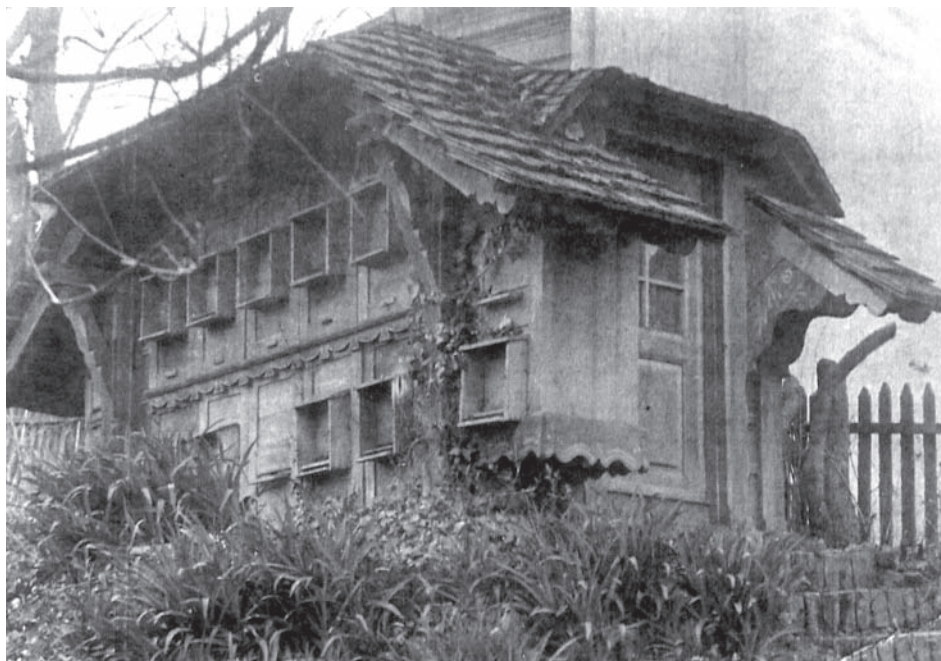
Aloisův včelín postavený dle návrhu architekta Dušana Jurkoviče, nedatováno (foto zapůjčeno ze soukromé sbírky)
