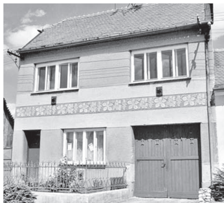
Dům čp. 40 v Dědině s vraty typickými pro Hlohovec, stav v roce 2002 (foto Jitka Matuszková)
