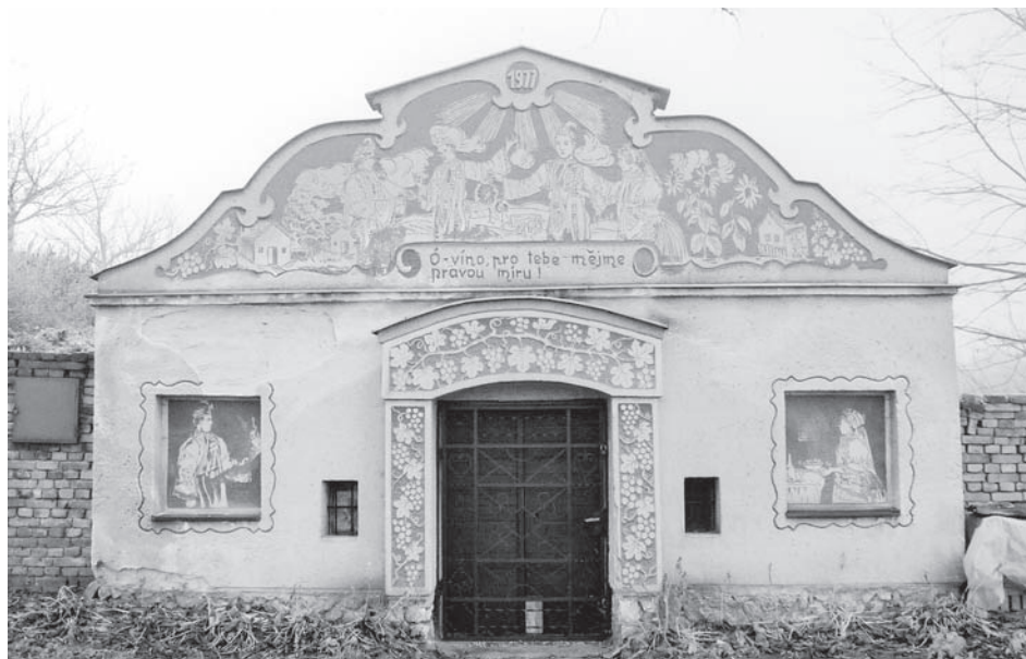
Sklep se zemní lisovnou, stav v roce 2003 (foto Jitka Matuszková)
