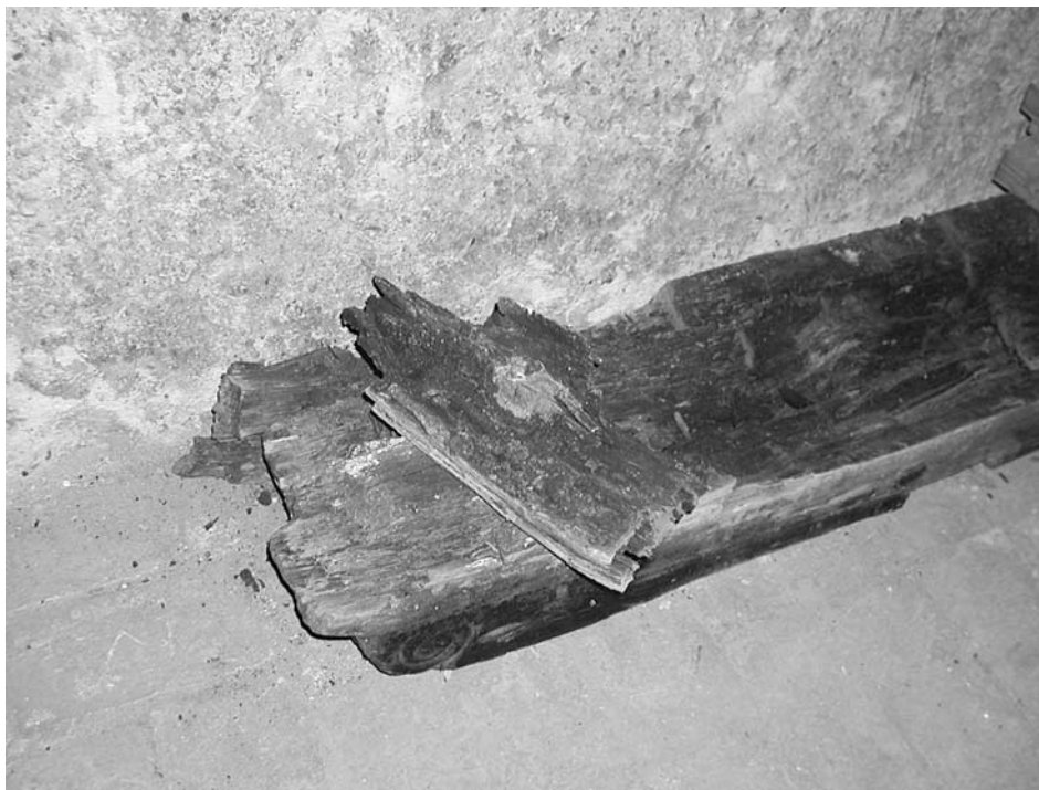
Trámy zničené dřevomorkou. (foto Jan Ivičič)
