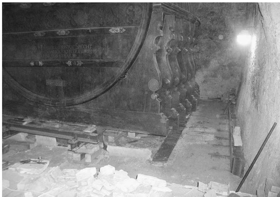
Kolos vyzdvižený na ocelových nosnících. (foto Jan Ivičič)
